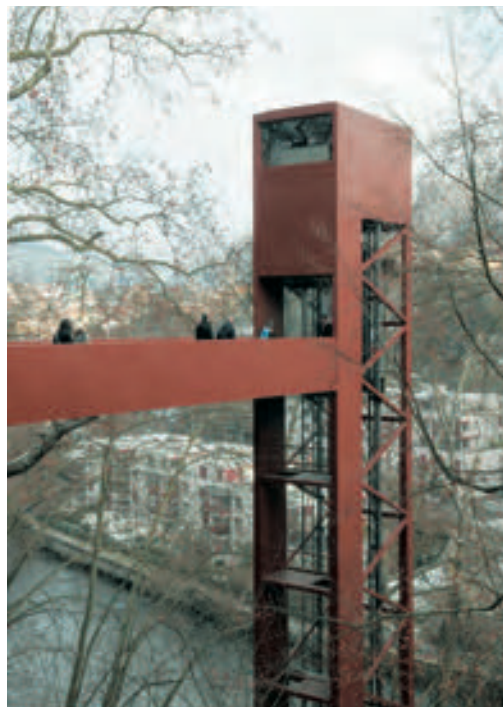
Ein Lift verbindet den Bahnhof Baden AG mit dem Limmatufer und über eine Brücke mit Ennetbaden. Foto: Tino Sand
