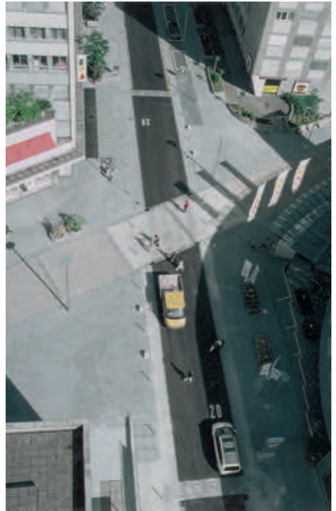
In Grenchen SO wurde mit Autobahngeldern die Hauptachse neu gestaltet und verkehrsberuhigt.
