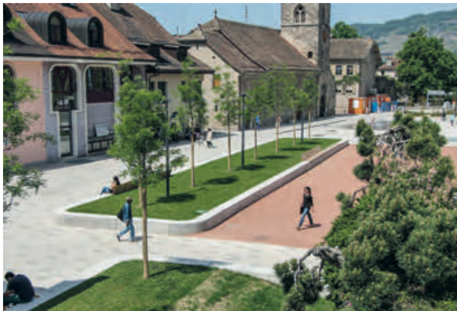
La création d'un parking souterrain a permis de transformer la place des Anciens-Fossés en zone piétonne.
