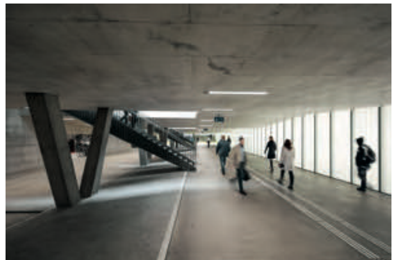
Die neue Quartierverbindung im Bahnhof Zürich-Oerlikon.
