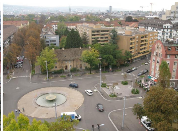
La Bullingerplatz dopo la riattazione (2012): ridimensionamento della corsia per le auto e allestimento della piazza, zona d'incontro
