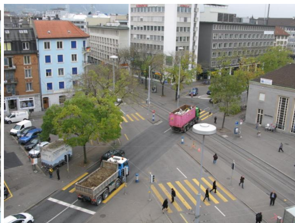
Nodo Schimmel-/ Birmendorferstrasse dopo la riattazione (2011): traffico nei due sensi, eliminazione della corsia di traffico individuale motorizzato, marciapiedi più larghi
