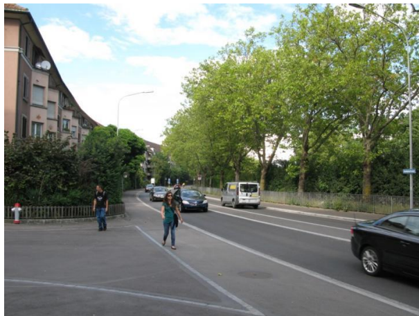
Seebahnstrasse dopo la riattazione (2012): via cittadina principale, traffico nei due sensi con striscia spartitraffico, trasferimento del traffico di transito sulla circonvallazione ovest
