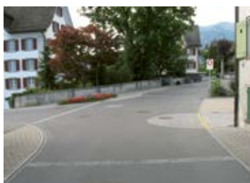
La pavimentazione a forma di mezzaluna segnala lo sbocco di un percorso pedonale e la presenza di un attraversamento
