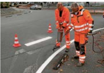
La manutenzione ordinaria e gli interventi minori sono realizzabili a basso costo.
