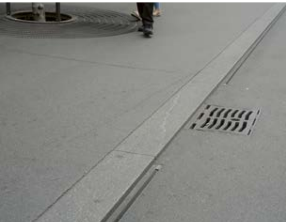
Cordolo basso (3 cm) e caditoia a griglia per l'evacuazione delle acque.
