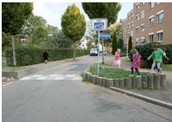
Zona d'incontro in un quartiere residenziale.
