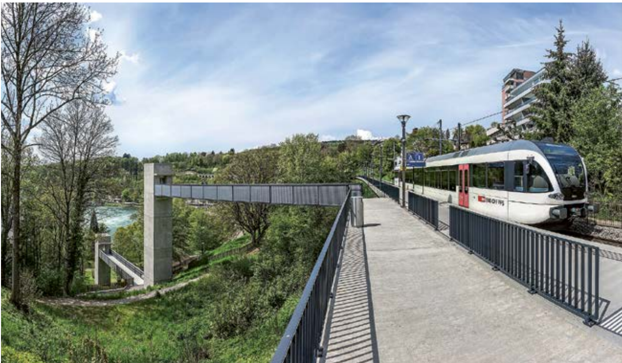
Un progetto faro per la mobilità pedonale: passerella di collegamento tra la fermata ferroviaria di Neuhausen e le cascate del Reno.
