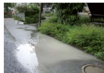
Pozzanghera che impedisce il cammino.
