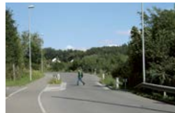
I restringimenti bilaterali della carreggiata accrescono la visibilità e mettono in sicurezza l'attraversamento.
