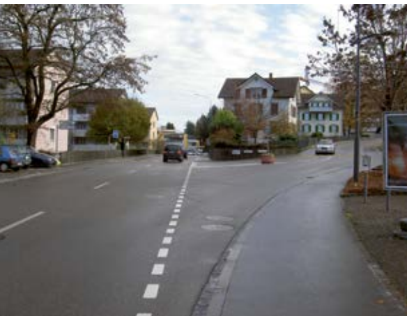
Attraversamento eccessivamente ampio, dove i veicoli circolano a velocità troppo elevata per il sovradimensionamento di area di circolazione e raggio di curvatura.
