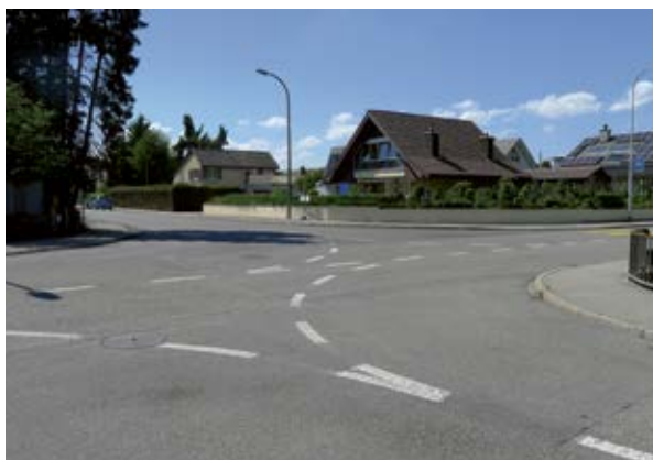
Sede stradale sovradimensionata in un quartiere residenziale.
