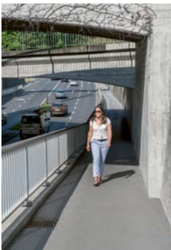
Innalzamento della corsia pedonale.
