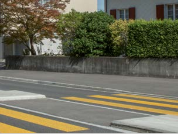
Marciapiede con cordolo alto abbassato a 3 cm in corrispondenza di un passaggio pedonale.
