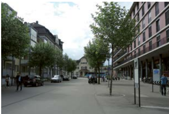
Strada a traffico misto in un quartiere commerciale nel centro di una località (zona d'incontro).
