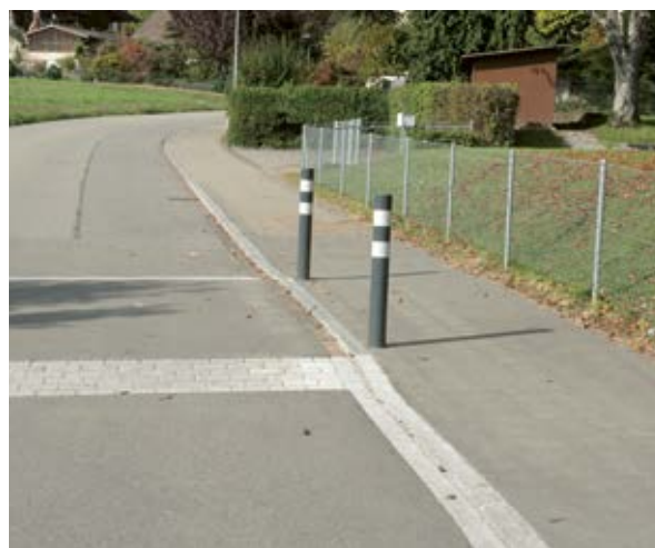
Attraversamento con dosso artificiale; i paletti impediscono ai veicoli di circolare sulla zona d'attesa.
