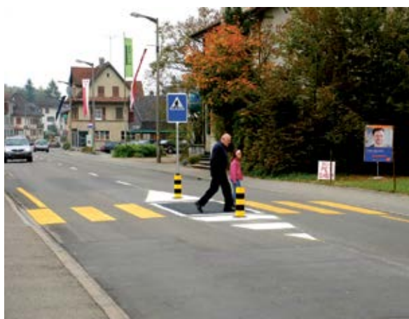
Isola spartitraffico contrassegnata sulla sede stradale e provvista di colonnine.
