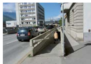
Assenza di attraversamento in superficie.
