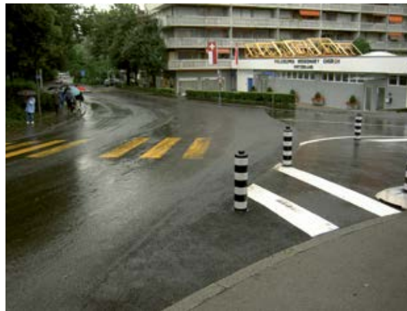
Situazione poco chiara, scarsa visibilità, assenza di delimitazione tra marciapiede e carreggiata, strisce pedonali sbiadite.
