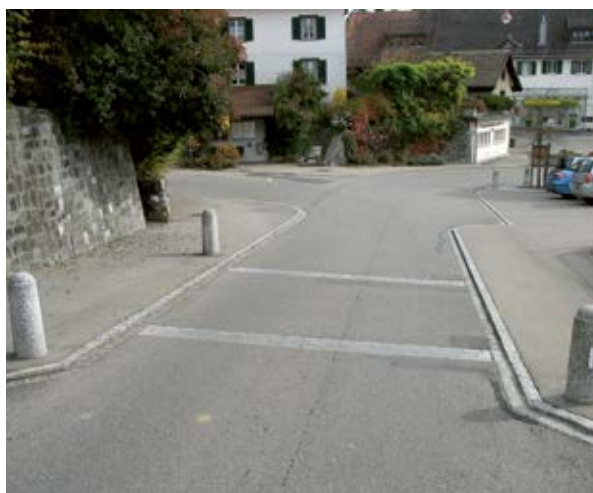
In presenza di cordoli bassi si possono collocare colonnine per migliorare la sicurezza dell'attraversamento.
