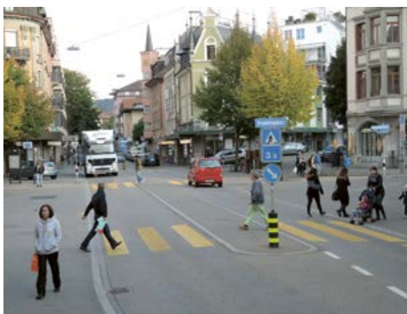
Le isole spartitraffico riducono la distanza di attraversamento e permettono di attraversare la carreggiata in due tappe.
